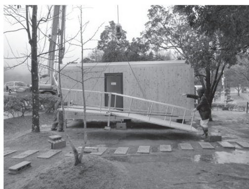
写真7. スロープ設置状況
