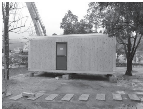
写真6. ハウス設置完了
