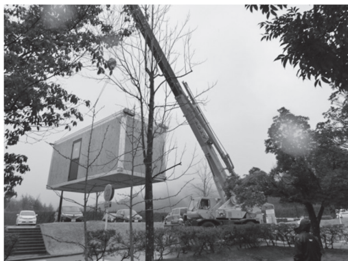
写真4. トラックつり上げ状況
