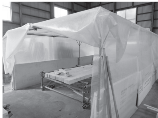
写真 2. パネル接着時の養生
