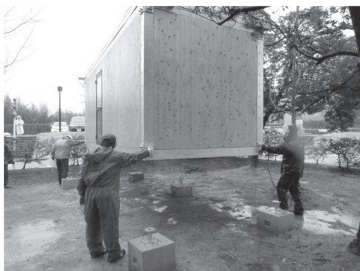
写真5. 基礎設置状況
