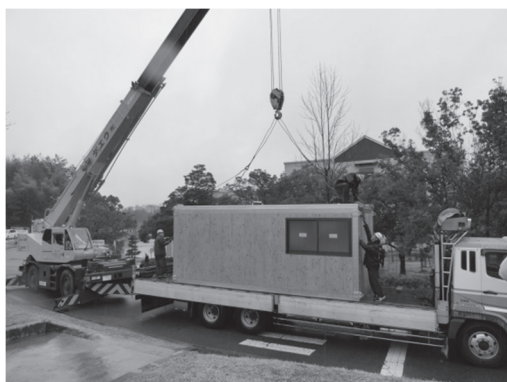
写真3. トラック及びクレーン設置状況
