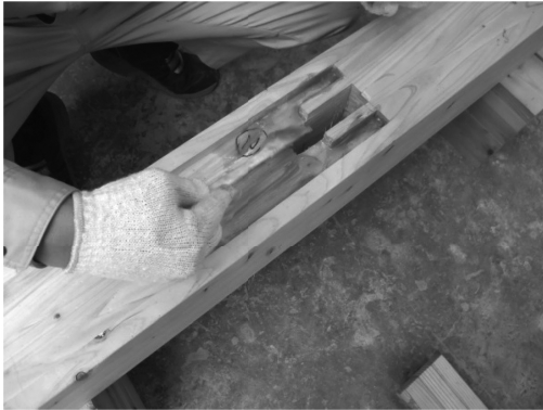
写真 10. 試験体 3 施工風景
