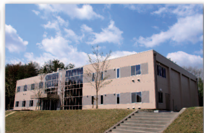
次世代基盤技術研究所・研究棟（工学部のある広島キャンパス（東広島市）内に設置（2010年3月竣工））
