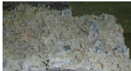
竹繊維を混入したコンクリートの断面
