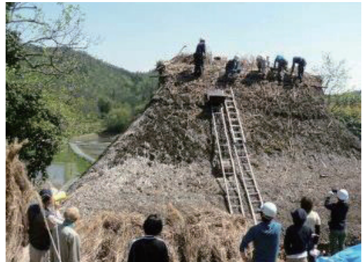
「豊栄の民家」葺き替えの様子
