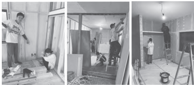
写真 27 断熱施工 写真 28 壁貼り 写真 29 漆喰塗り
