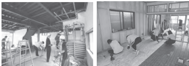
写真 25 解体の様子 写真 26 床板貼り工事の様子
