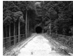
写真1 トンネル北西入口
