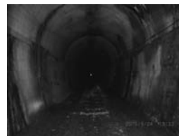
写真3 トンネル内部 (北西→南東)
