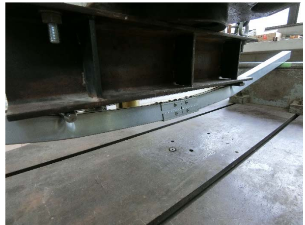
写真 6 試験体の終局状況 (□45×45×1.2・外金物板厚 1.6mm)
